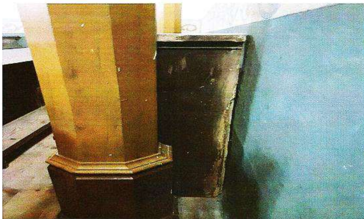
Fot. 5. Parsowo, kościół pw. Św. Piotra i Pawła, fragment słupa i cokolu pokryty farbami olejnymi.
